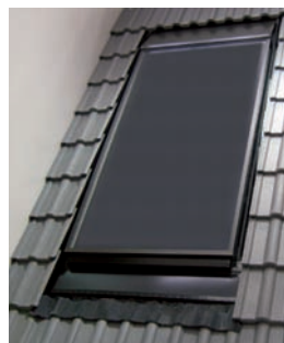
1 коллектор, встроенный в крышу из штампованной черепицы
