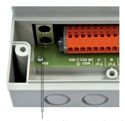
Кабель BUS (ед. поставки AD 134, AD 124 или DB 119) должны подключаться на один из 2 разъёмов с маркировкой BUS.
